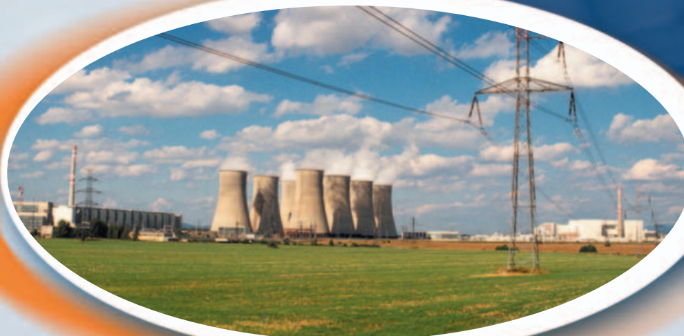
Jadrové elektrárne V1 a V2
